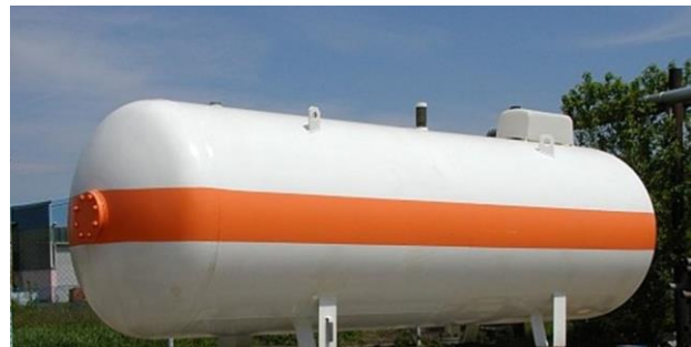
Slika 28. Spremnik UNP-a s opremom [8]
