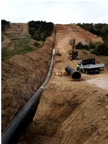
Slika 23. Izgradnja magistralnog plinovoda [5]
