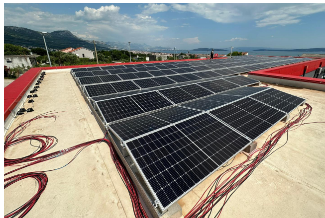
Slika 8. Spoj fotonaponskih modula [izvor: rad autora]
