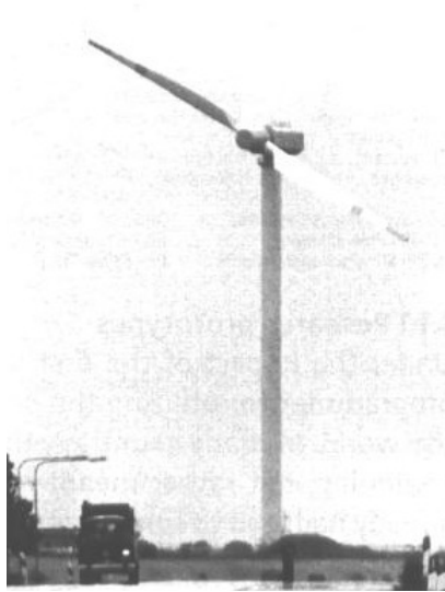
Slika 21. WTS-3 MAGLARP (3000 kW; D= 78 m; ŠVEDSKA 1982.) [3]
