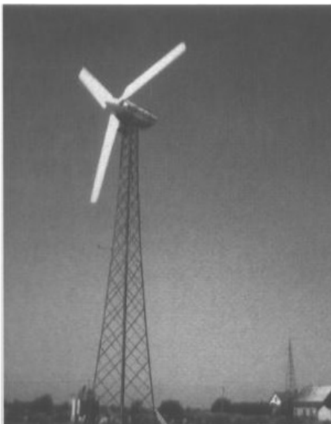
Slika 27. VESTAS V15-55 (55 kW; D= 15 m) [8]
