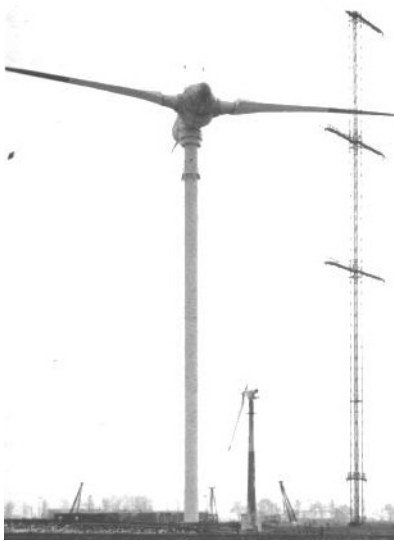
Slika 20. GROWIAN (3000 kW; D= 100 m; NJEMAČKA 1982.) [3]
